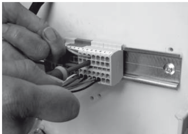
Заказчик должен подключить скорости термостату, расположенному в верхней части блока электрических подключений между V1 и V5.
